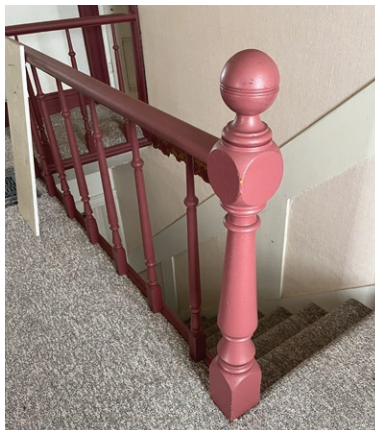
Wood balustrade (ERA, 2024).
