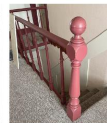
Wood balustrade (ERA, 2024).
